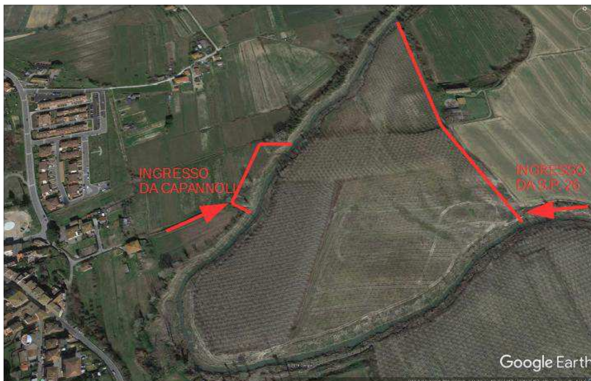
Figura 2 – Inquadramento area futuro cantiere
